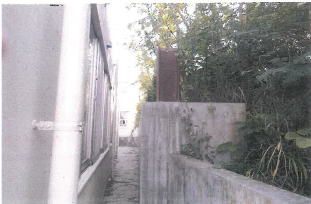
物件8南側未利用地付近の状況
