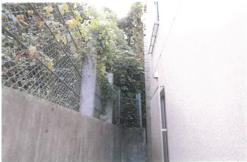
物件10東側未利用地付近の状況
