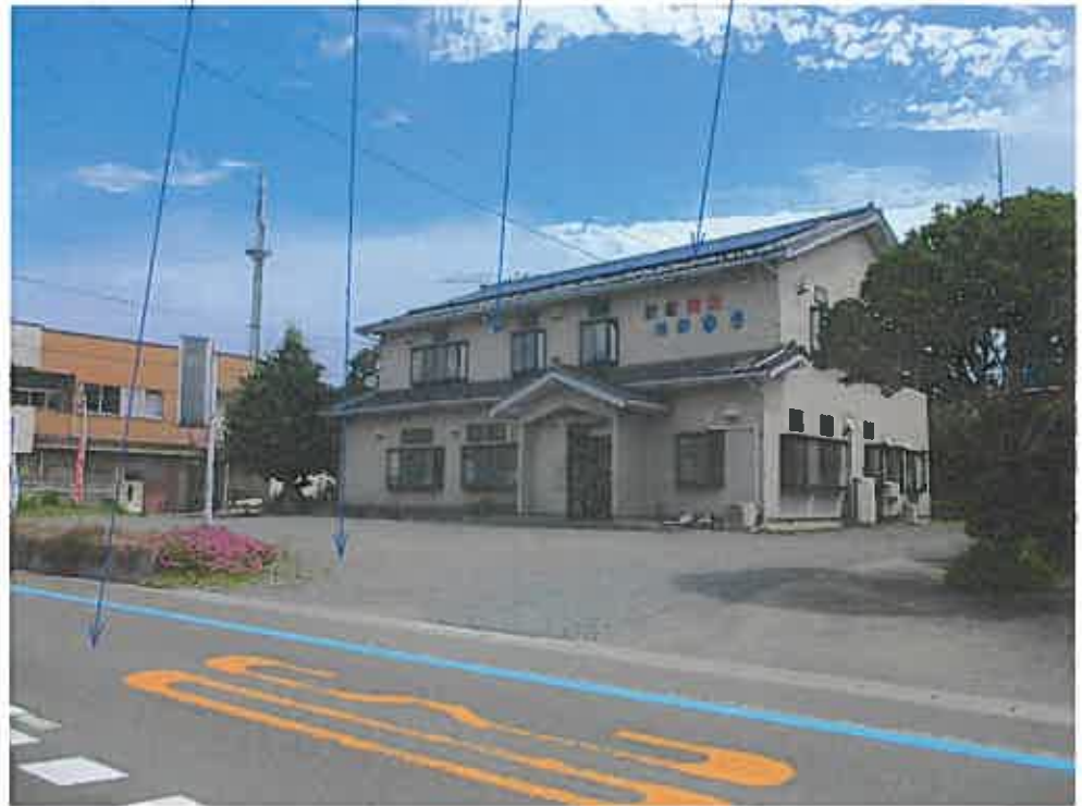
写 真 1 県道 物件1 物件5 ソーラーパネル
