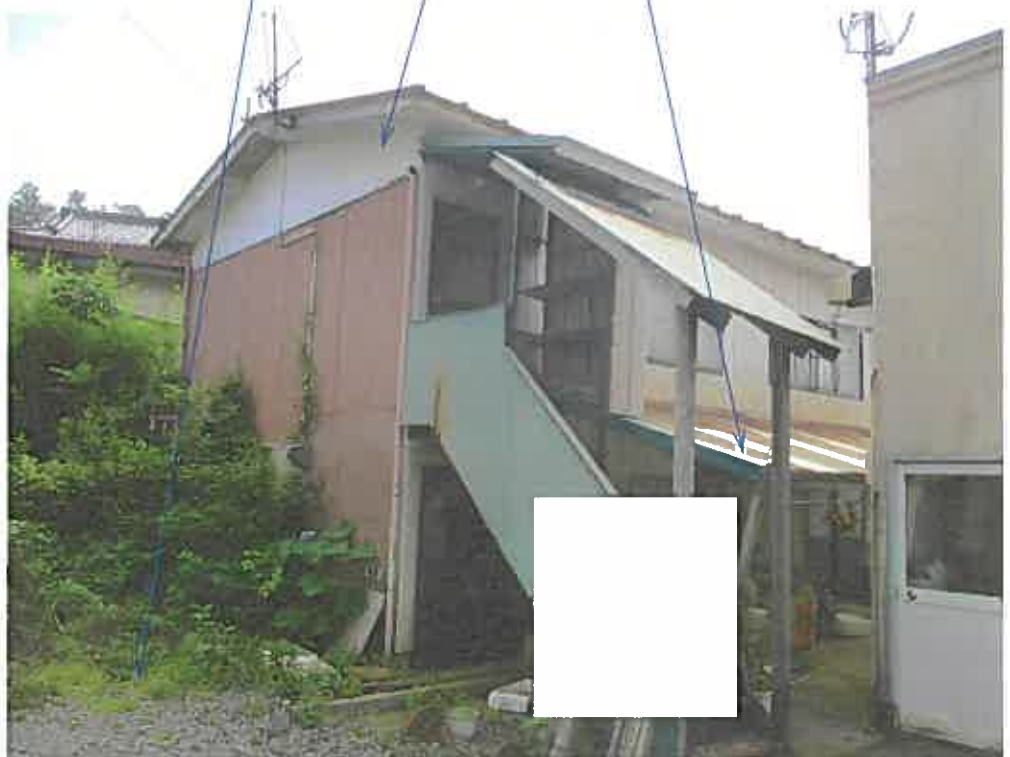
写 真 2 物件1 物件3 下屋
