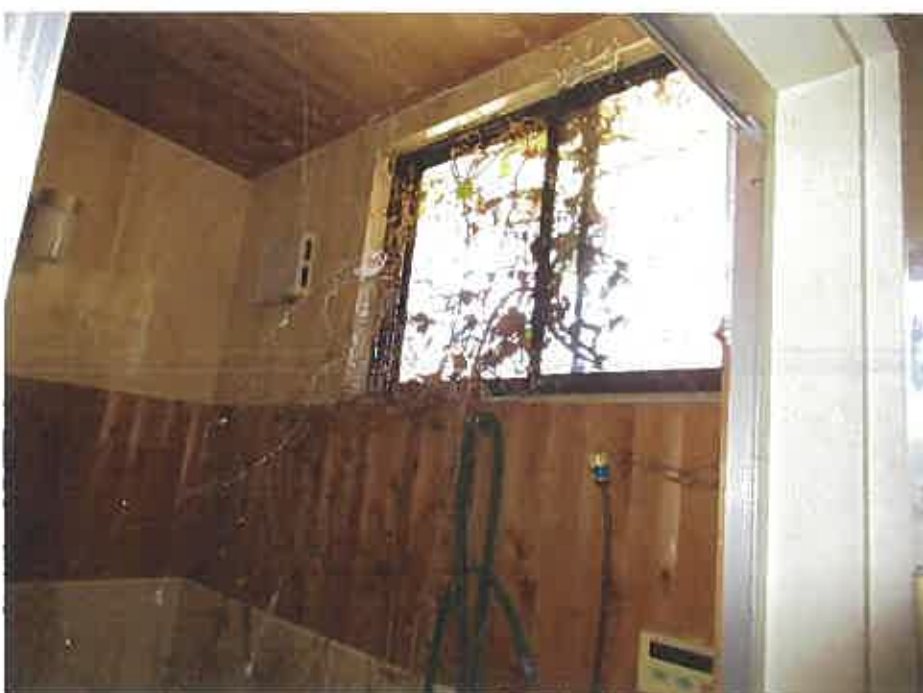
物件2:主である建物1階浴室の状況
