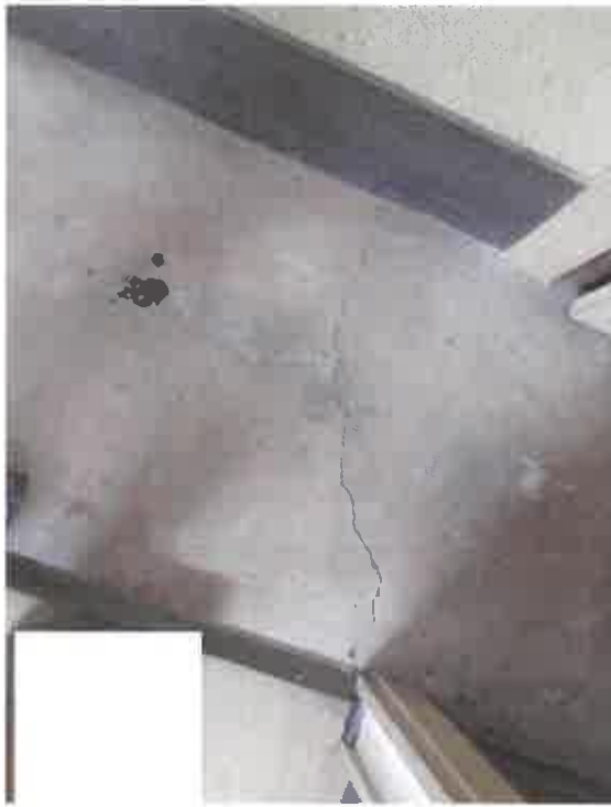
物件3:1階廊下のひび割れ状況
