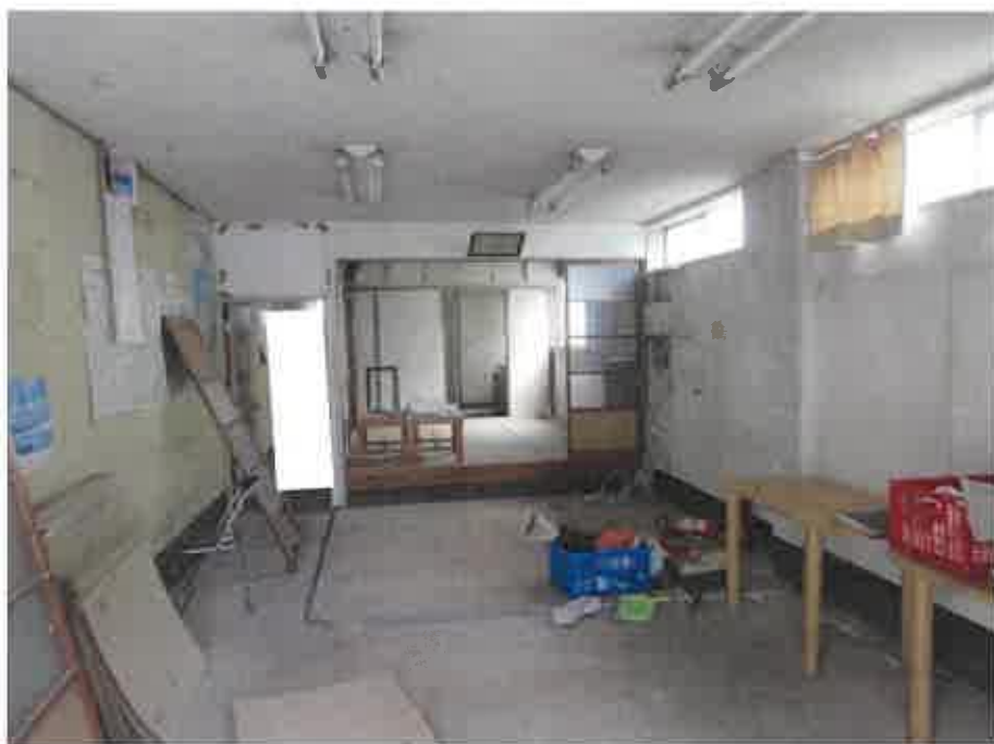
物件3:1階店舗部分の状況
