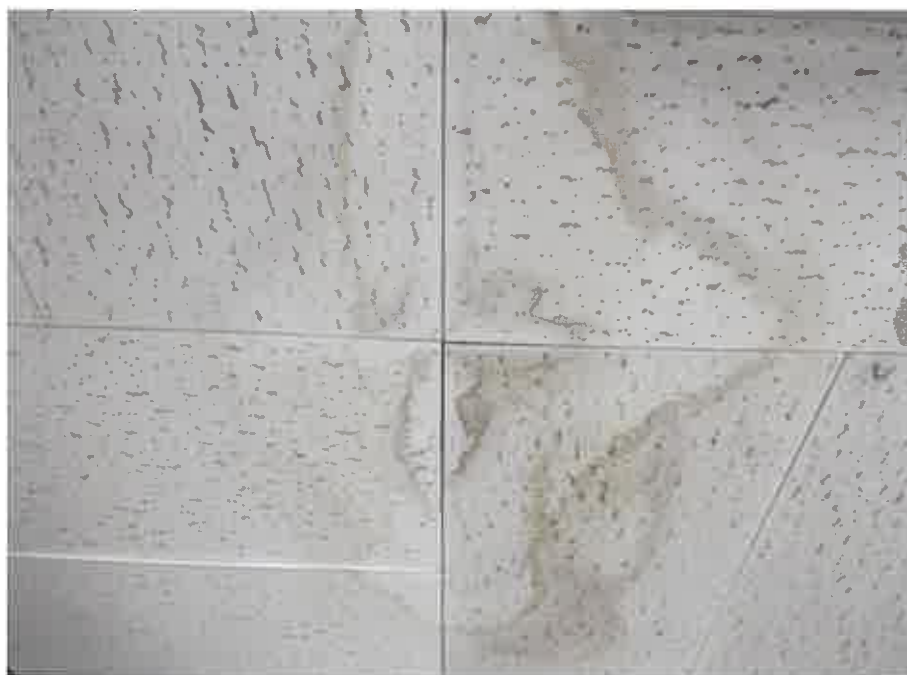
物件3:2階台所の天井の染み
