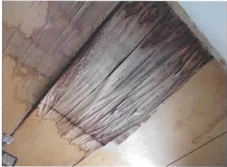
物件3:3階和室天井の雨漏り痕
