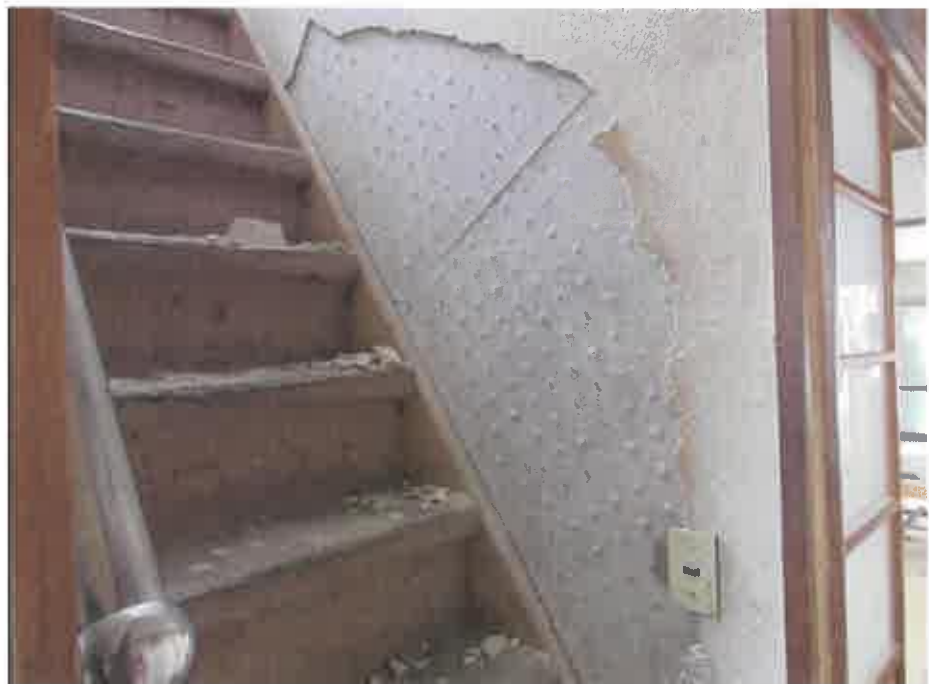
物件3:1階階段部分の壁の剥離
