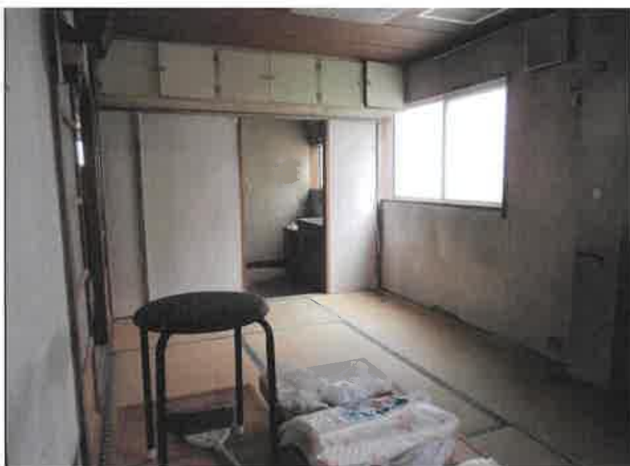
物件3:1階和室の状況
