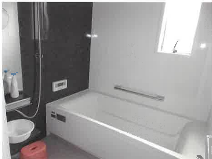
物件3:1階浴室の状況
