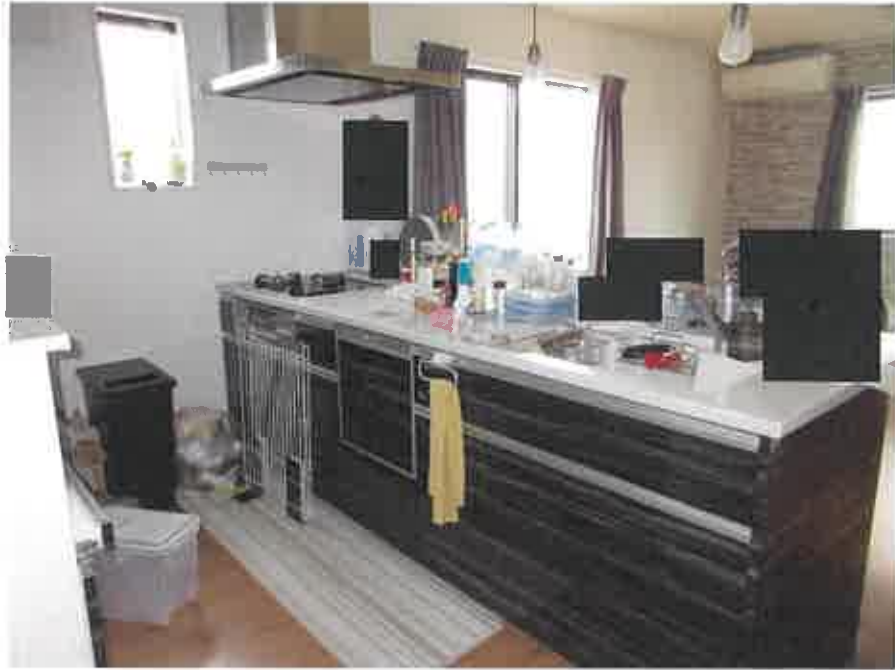
物件3:1階キッチンの状況
