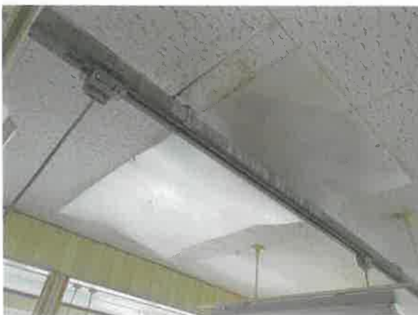
物件5:主である建物1階工場の天井
