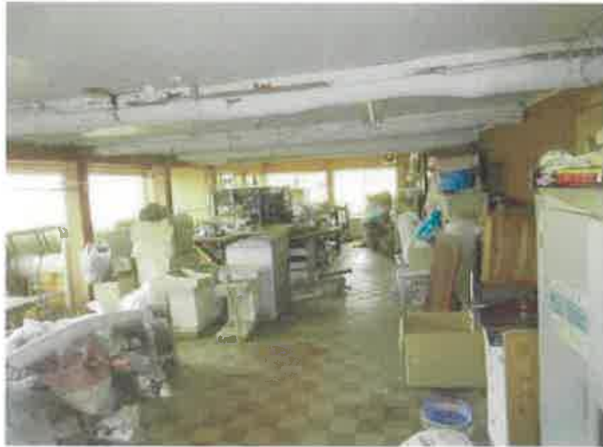
No. 19 物件4：主である建物1階北西側物置
