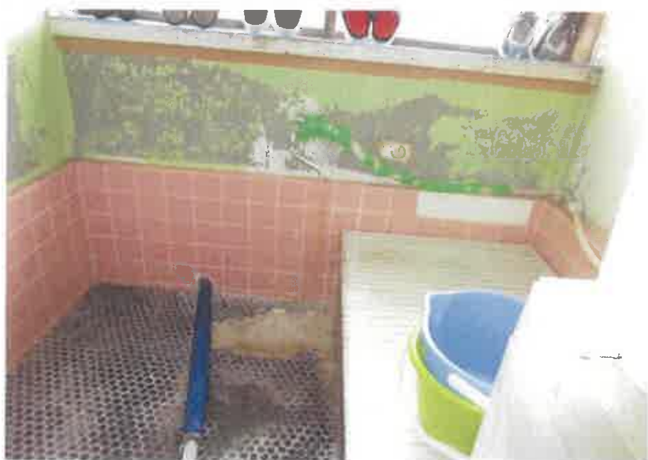
物件2:1階浴室の状況
