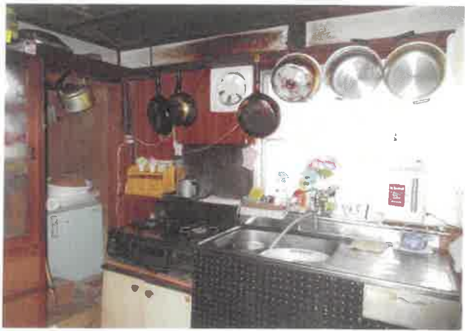
物件2:1階台所の状況
