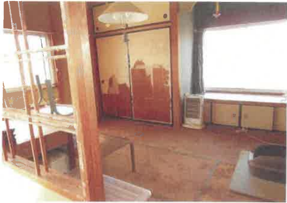
物件2:2階南西側和室の状況
