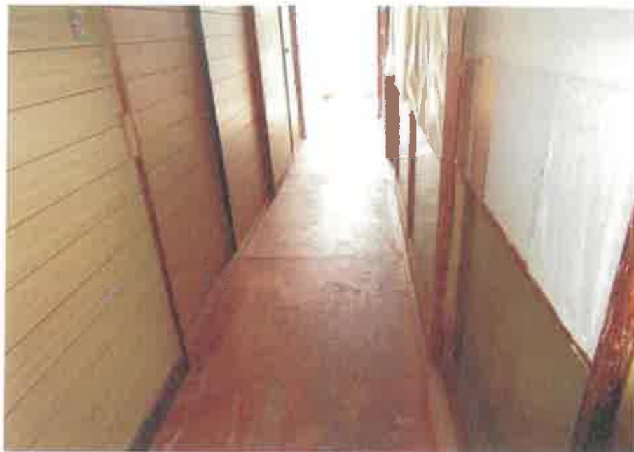
物件2:2階廊下の状況
