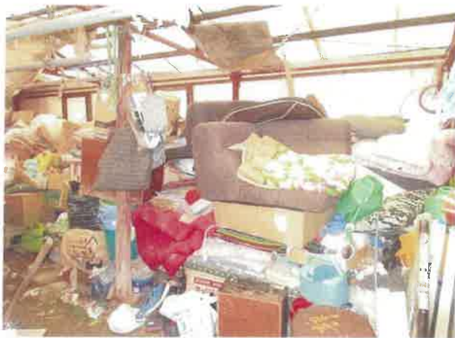
構築物(物置)の内部の状況
