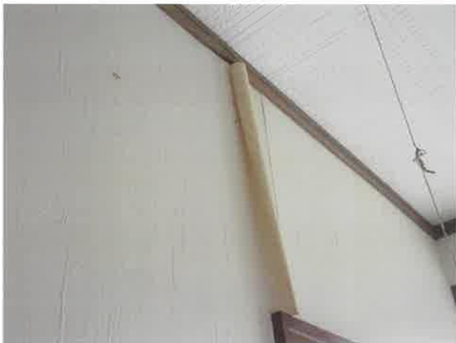
物件3:2階廊下の壁クロスの剥離状況
