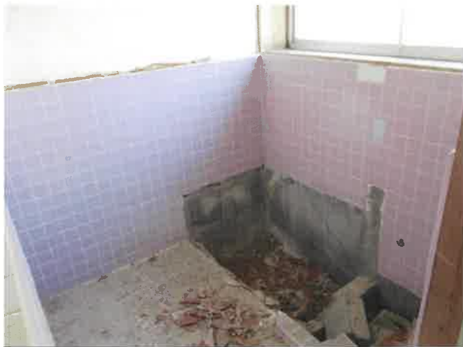
物件7:附属建物3(未登記) 浴室の状況
