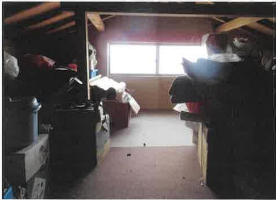
物件7:主である建物 屋根裏部屋の状況
