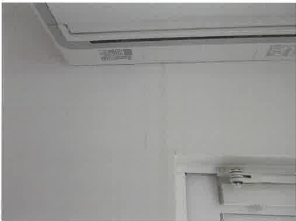
物件2:1階LDKの壁クロスの亀裂
