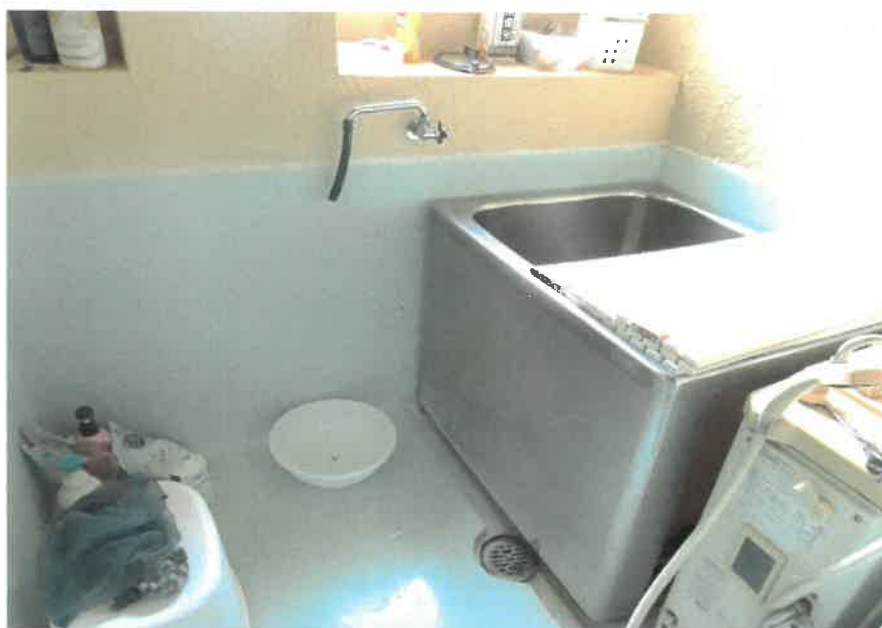
物件2:3階浴室の状況
