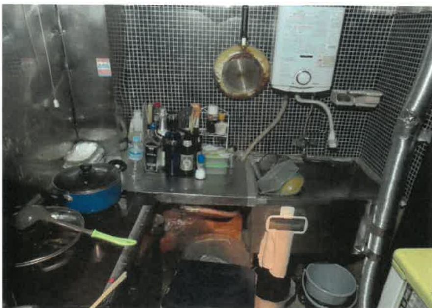
物件2:1階西側店舗(厨房)の状況
