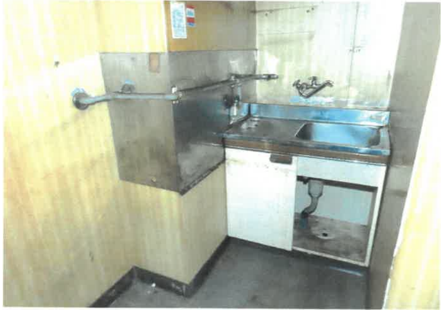
物件2:1階東側店舗(厨房)の状況
