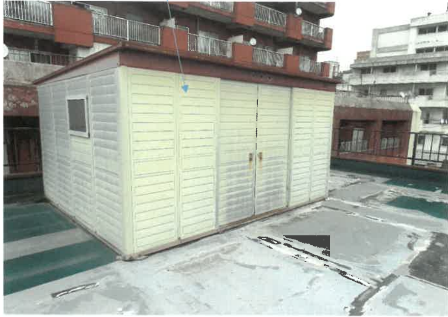
物件2:屋上の状況
