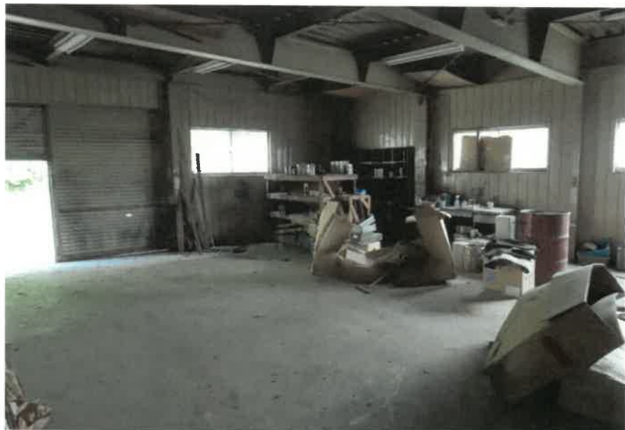
物件4主である建物:2階東側作業場の状況
