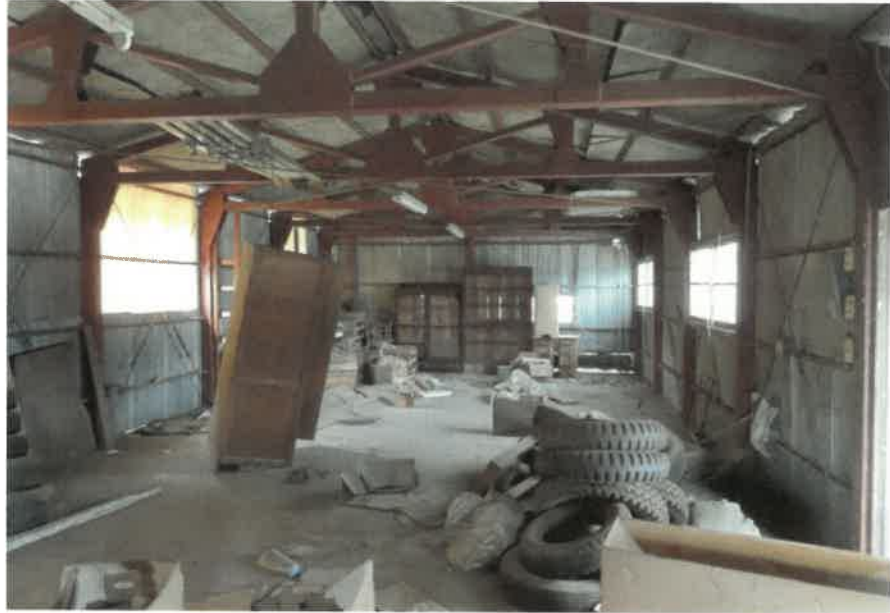
物件3:2階倉庫の状況
