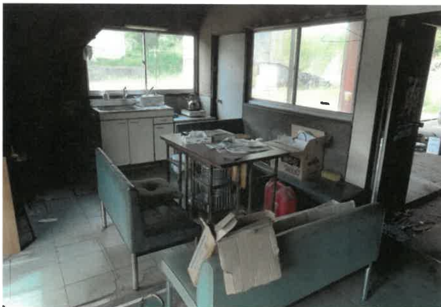
物件4主である建物:1階事務所の状況
