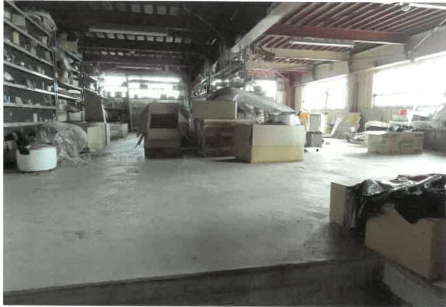
物件4主である建物:2階倉庫の状況
