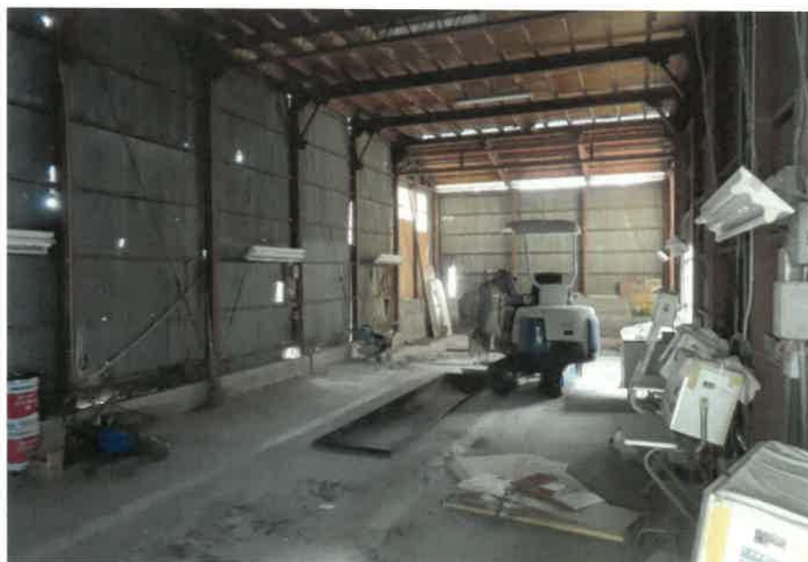
物件3:1階工場の状況
