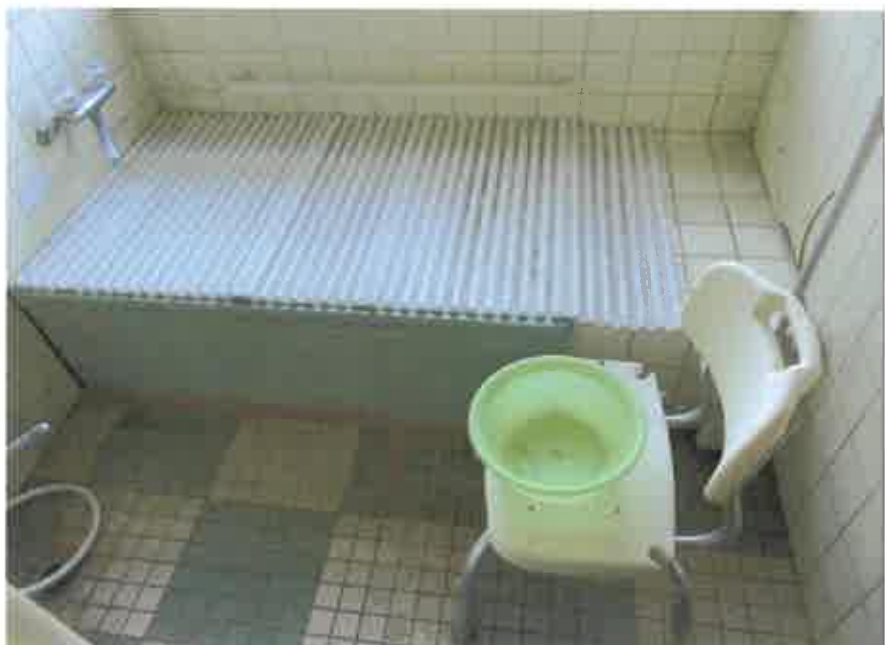
物件1:浴槽と床タイルの亀裂をガムテープで補修した状況
