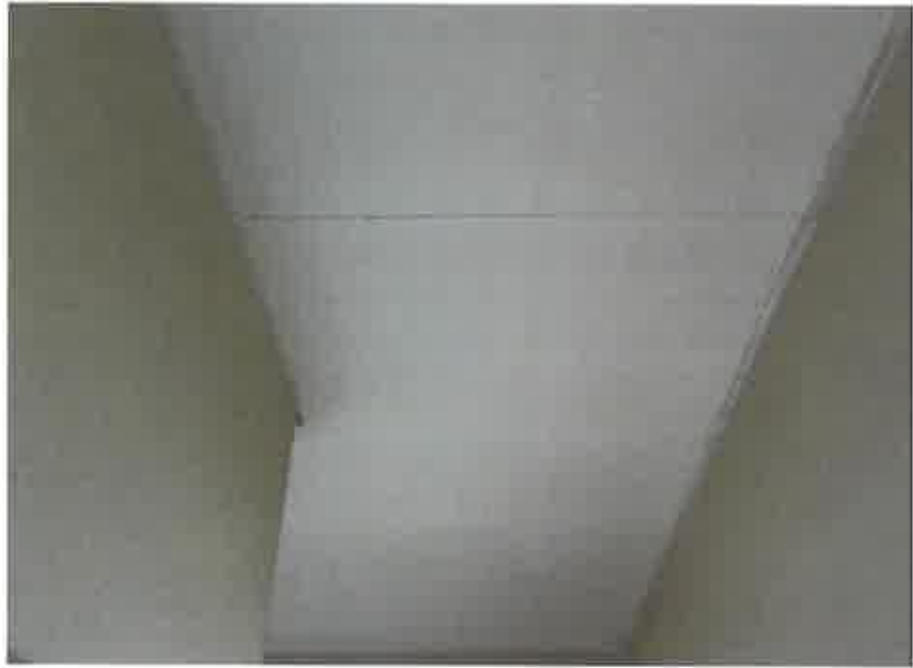
物件1:廊下天井板の亀裂
