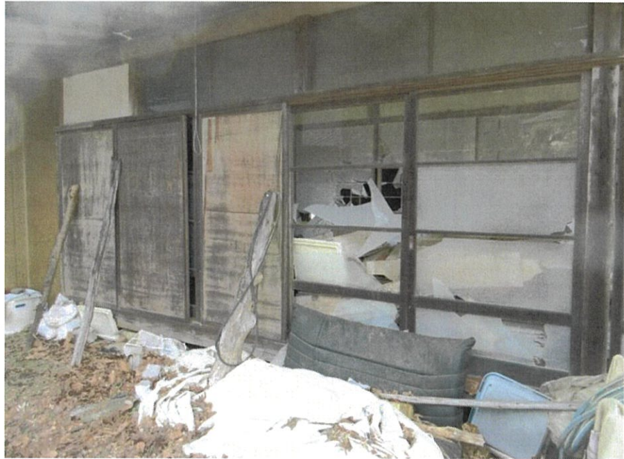
物件3:廊下部分の建具の状況
