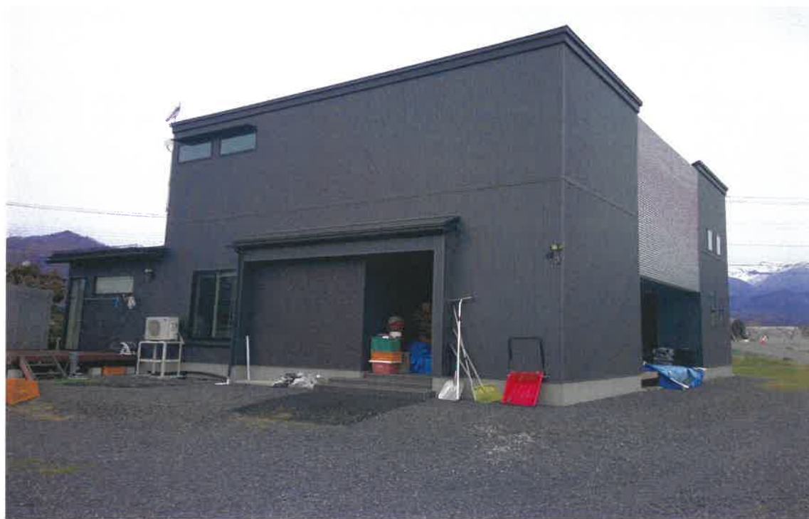
写真① (建物外観 西側玄関付近)
