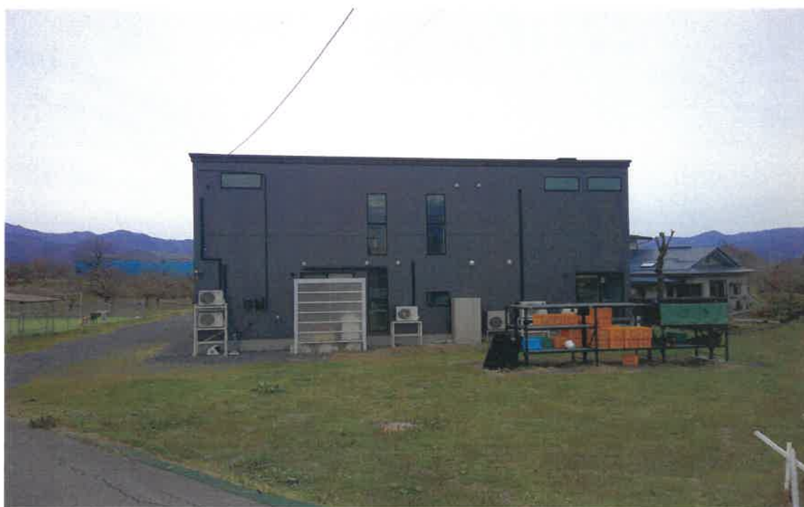
写真② (建物外観 東側道路付近)
