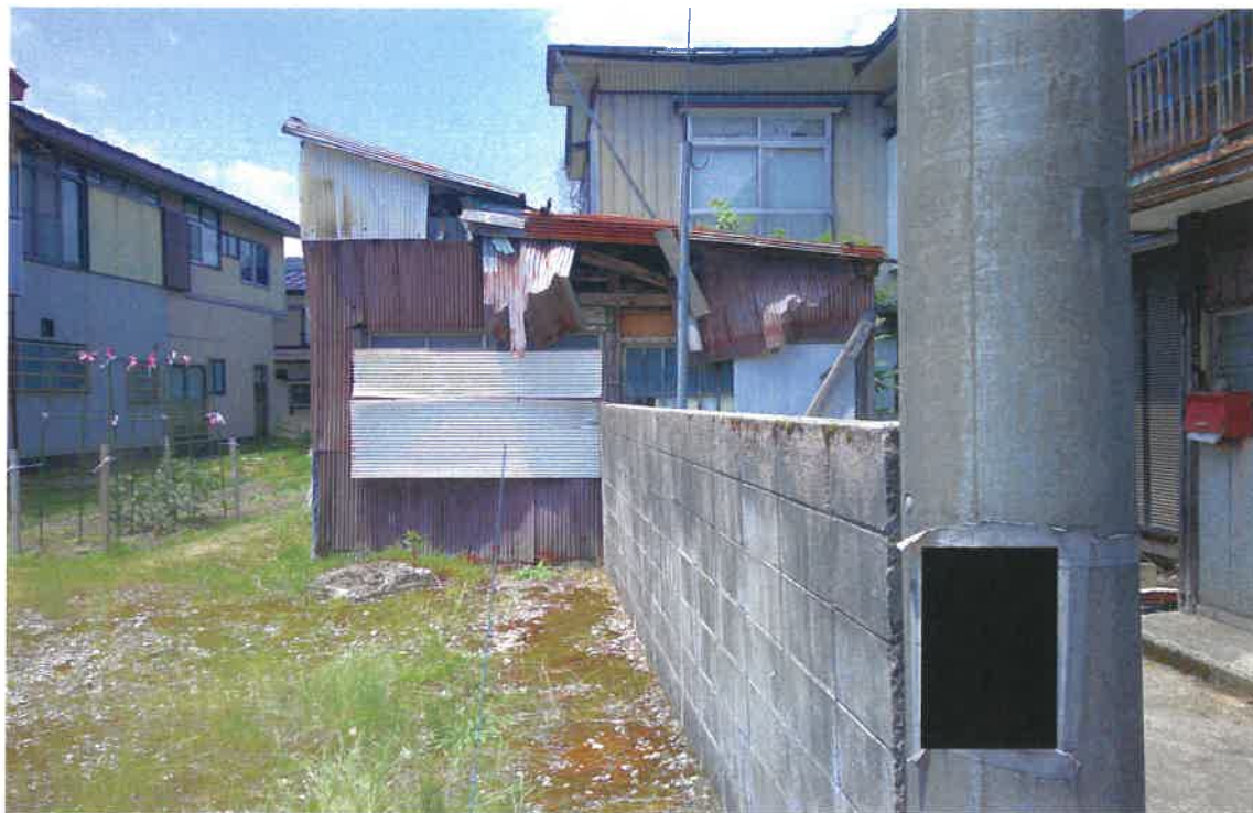
写真⑦(物件2 北側 目的外動産である仮設物置側面)
