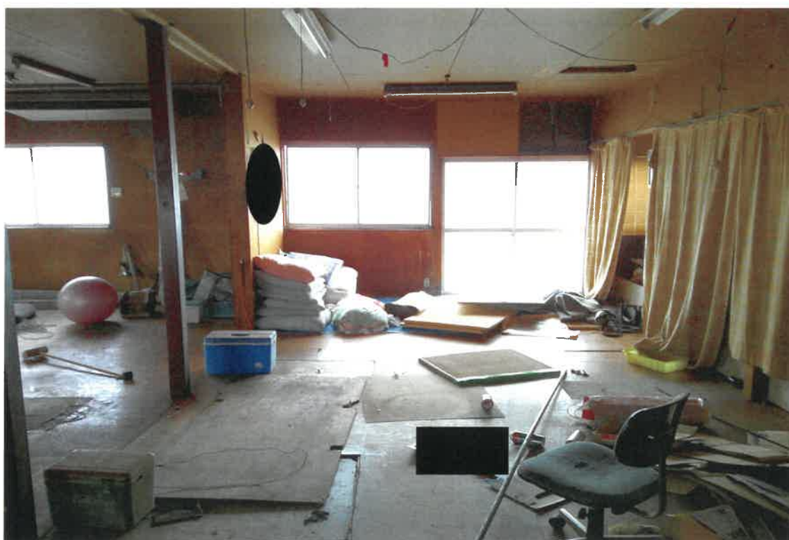
写真④(物件4 1階 作業場東側)
