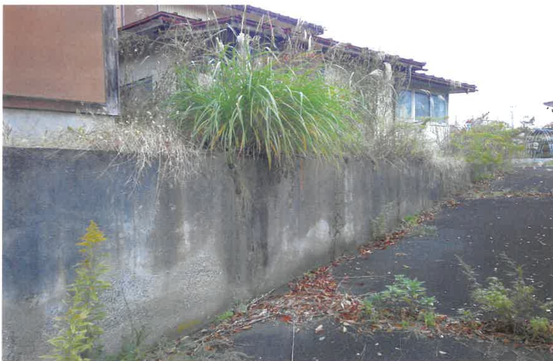
写真②(物件 3 東側境界付近)
