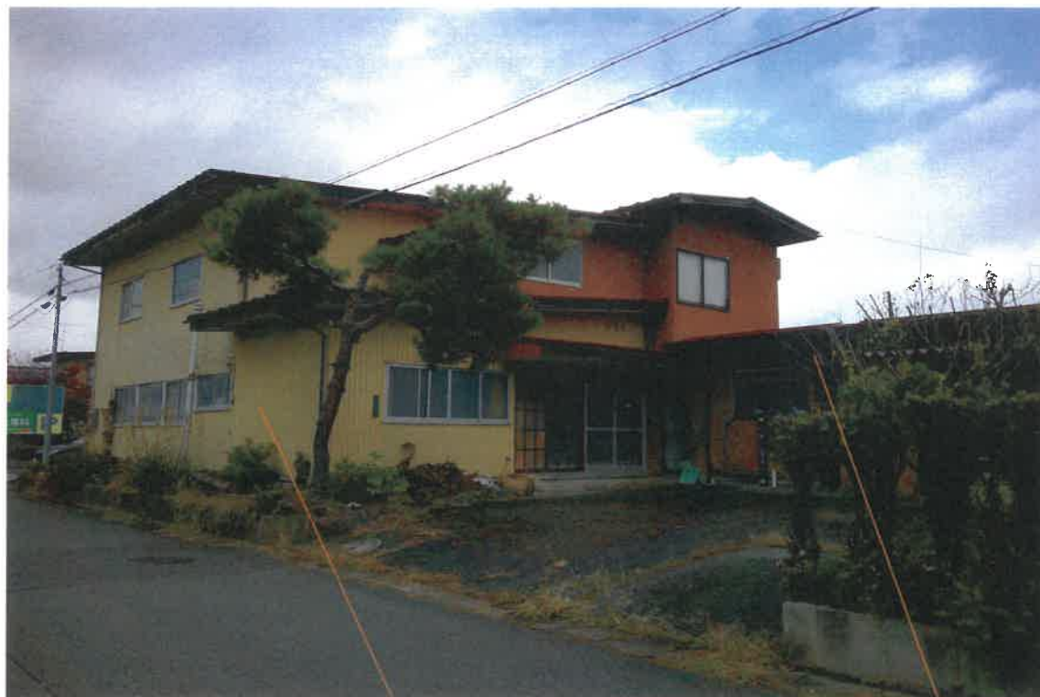
写真①(建物外観)
