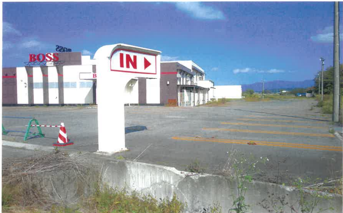
写真③(一体地 南側駐車場)
