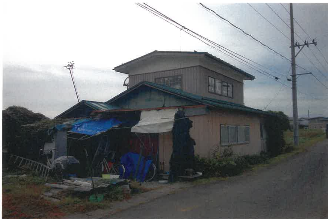
写真①(建物外観)
