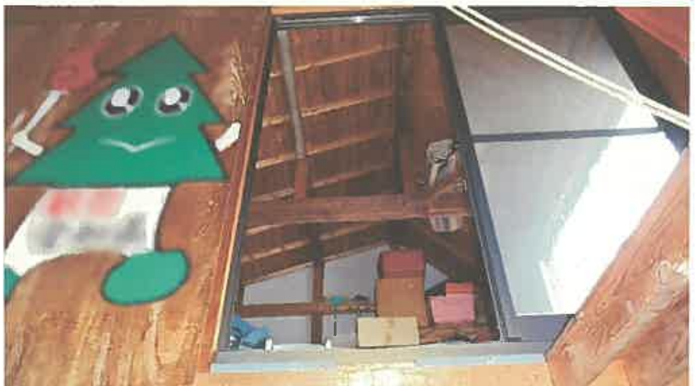
物件 2 未登記附属建物内部の状況（中 2 階）
