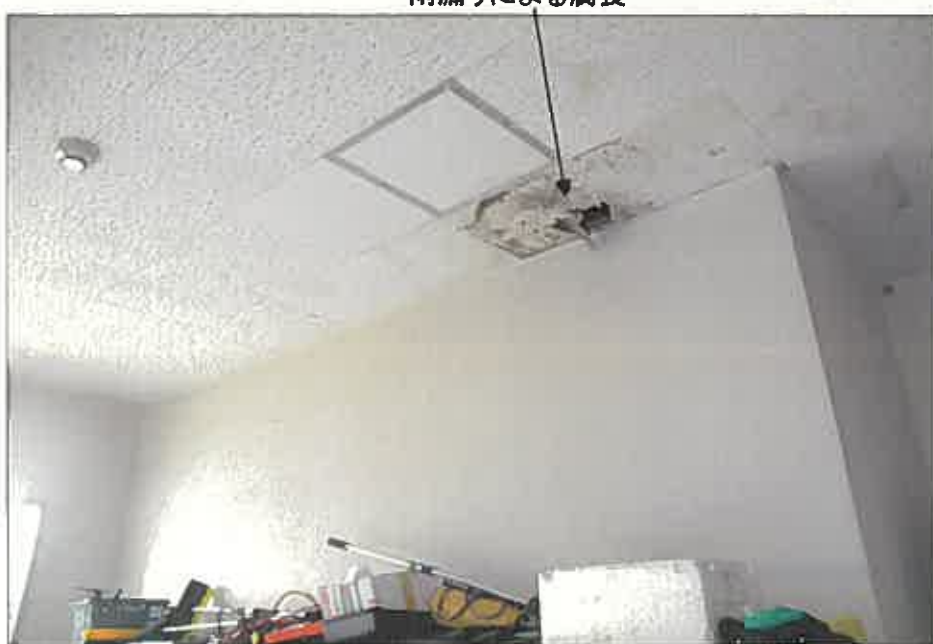
雨漏りによる腐食
