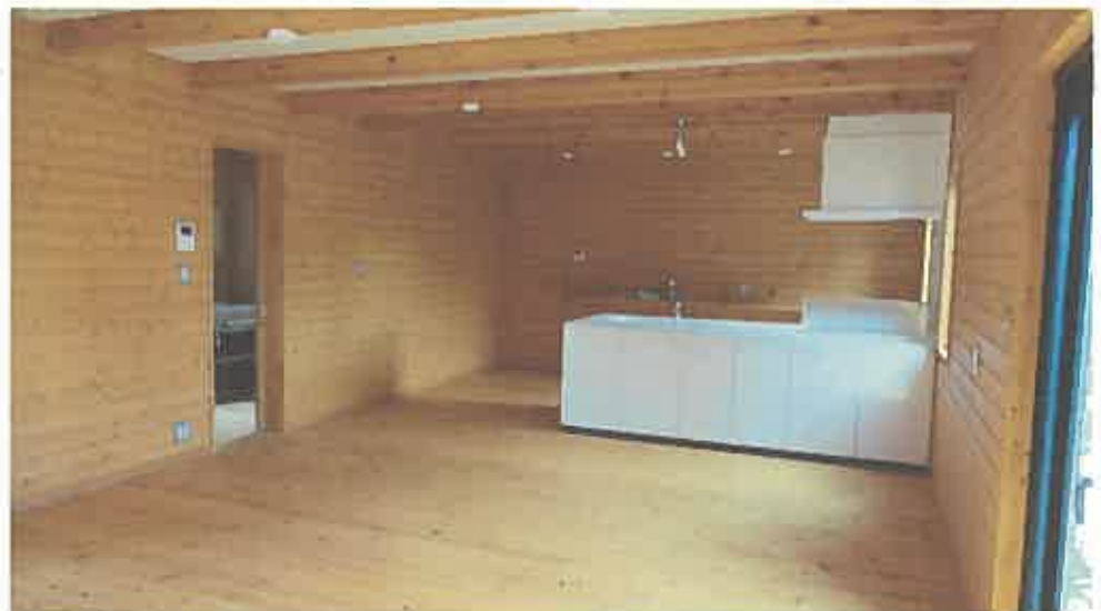
物件 2 建物内部の状況 (1 階)
