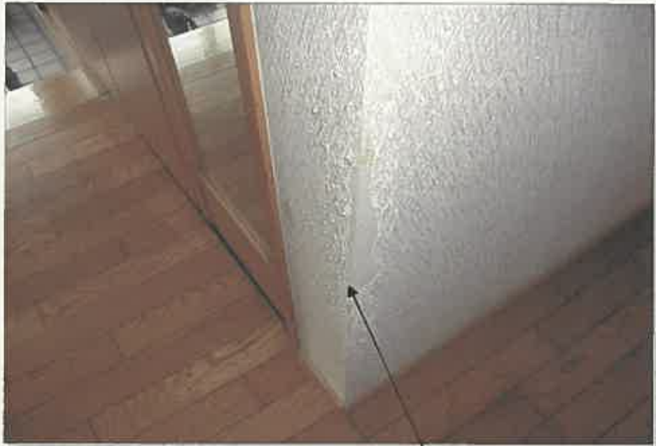
壁クロスの損傷
