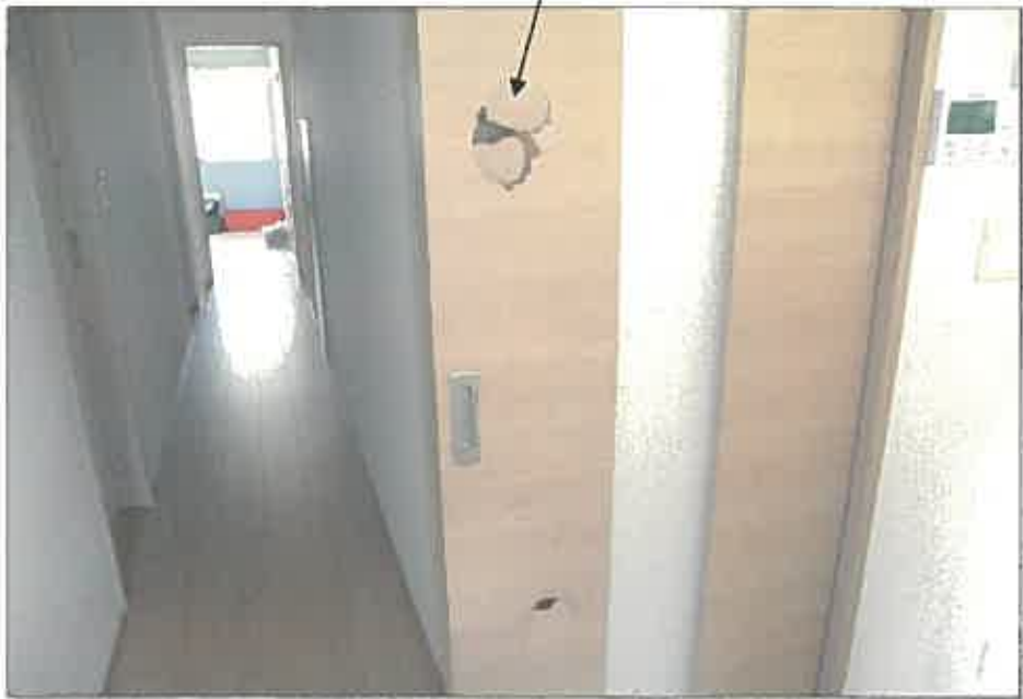
ドアの損傷
