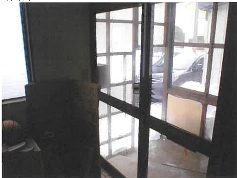
物件 6 風除室部分
