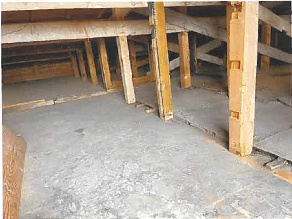
物件 2 2階屋根裏部分
