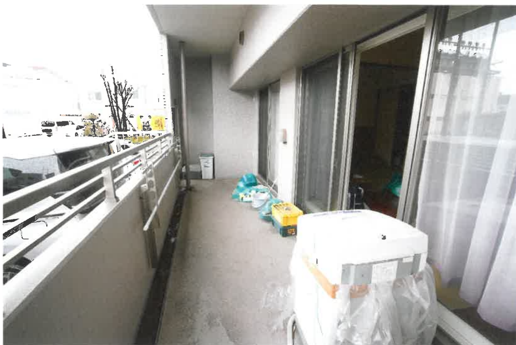
バルコニー（共用部分）
