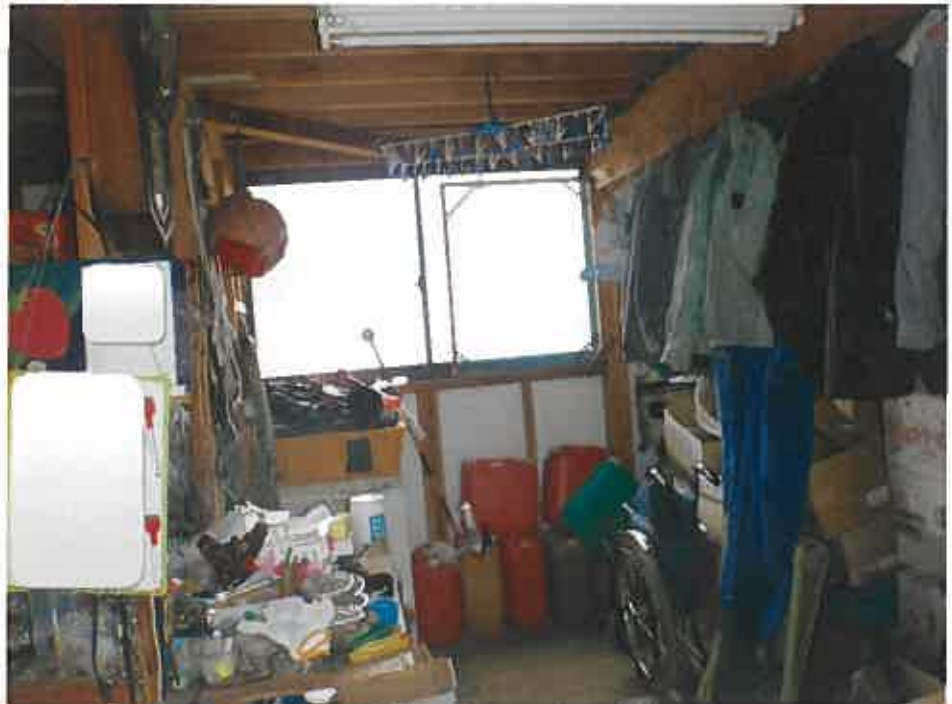
物件2 未登記附属建物1階作業場
