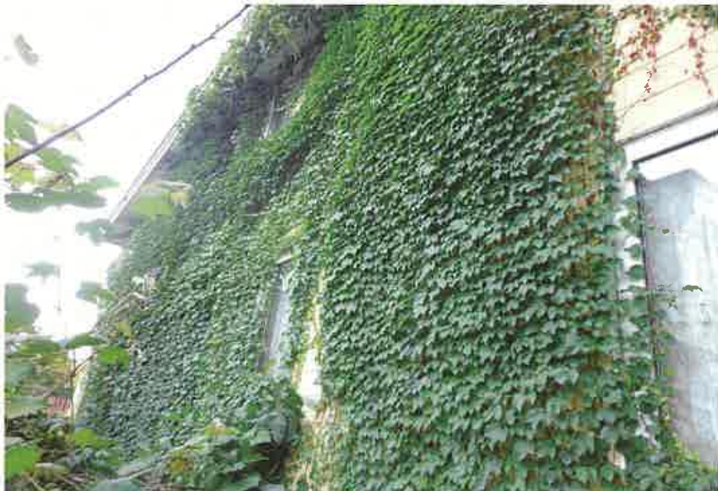
北西側の外壁の状況
