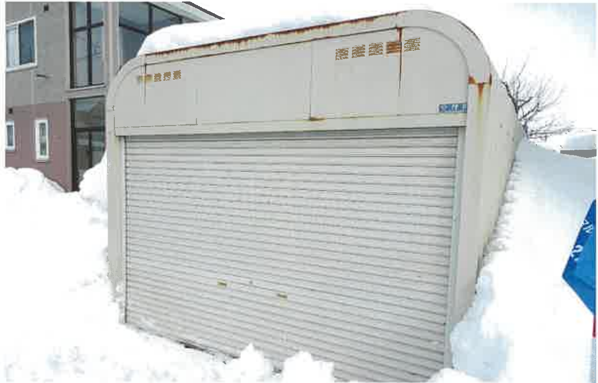
6 車庫（未登記附属建物）
