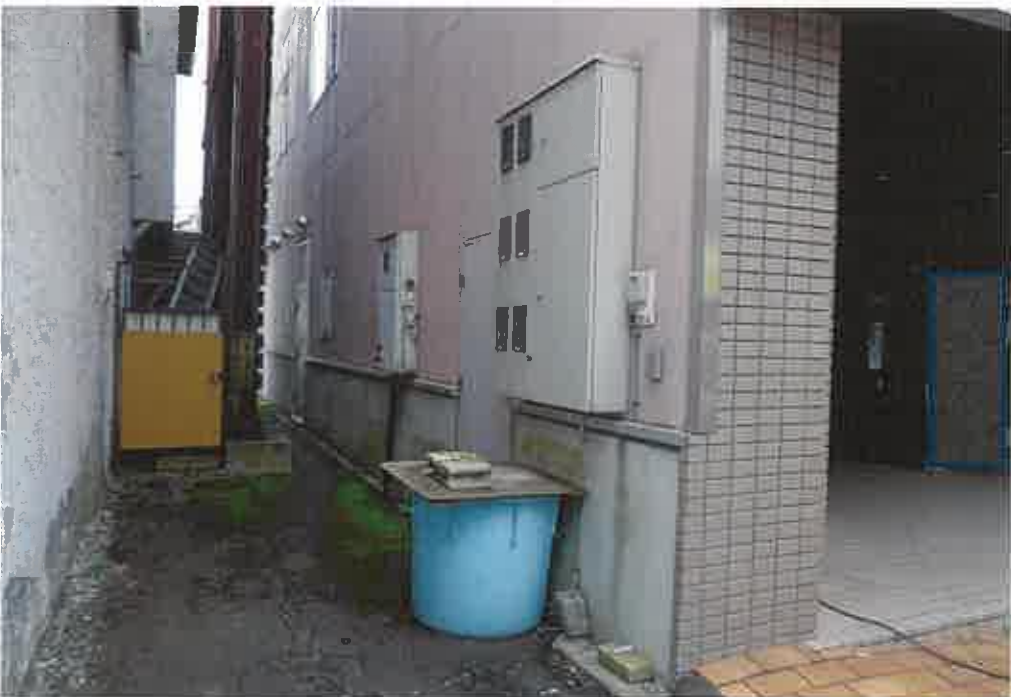
1階 物置出入口付近
