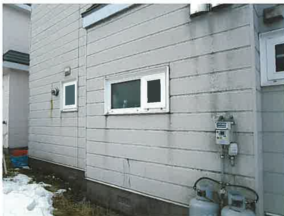
北東側の外壁
