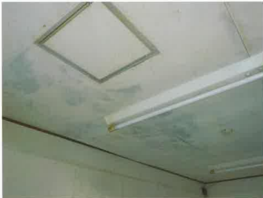
1 階作業室の天井
