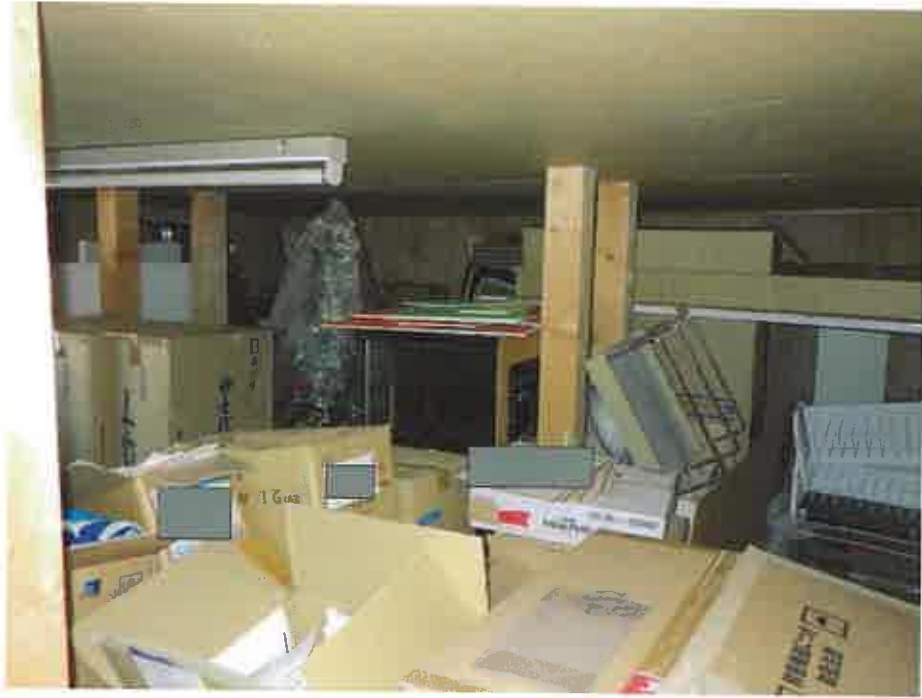
3 階倉庫（増床部分）
