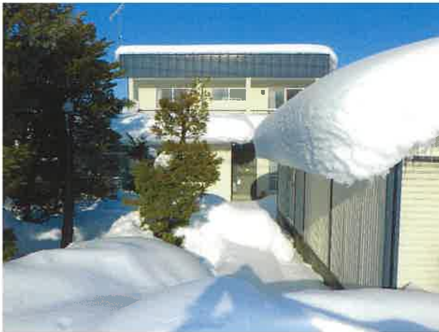
本件土地の形状、本件建物の外観
