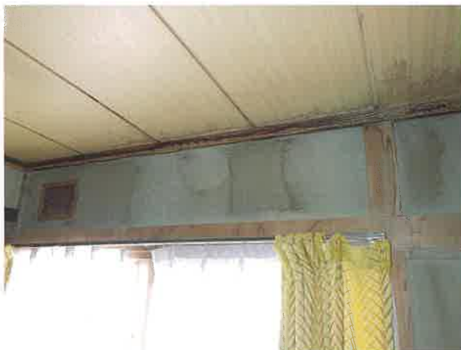
和室 1 の天井付近
