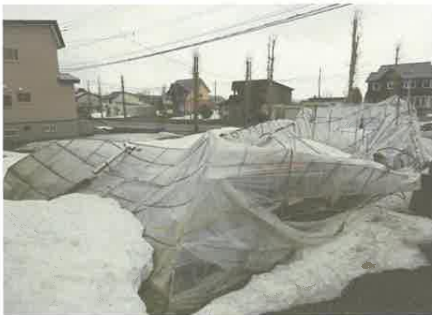
雪の重みで倒壊したビニールハウスの状況
