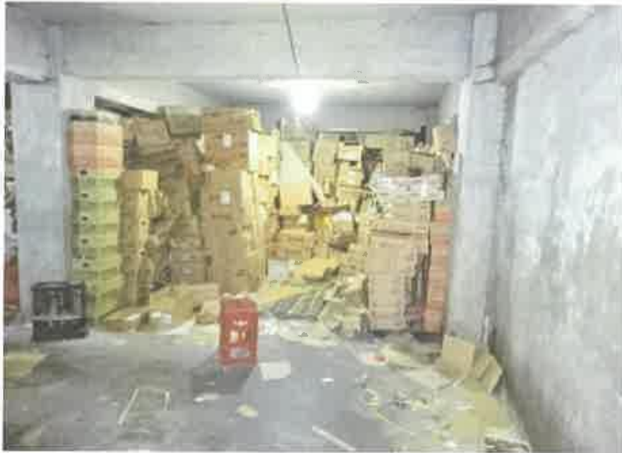
地下1階の倉庫の状況
