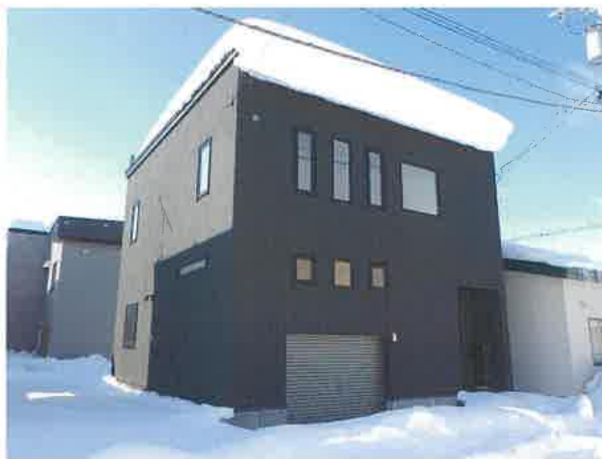
本件土地の形状、本件建物の外観
