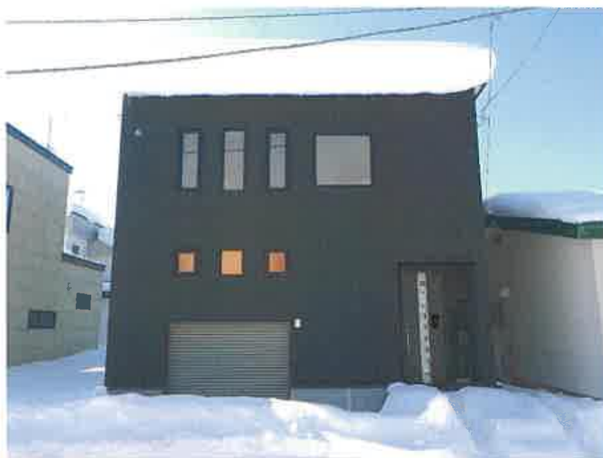
本件土地の形状、本件建物の外観
