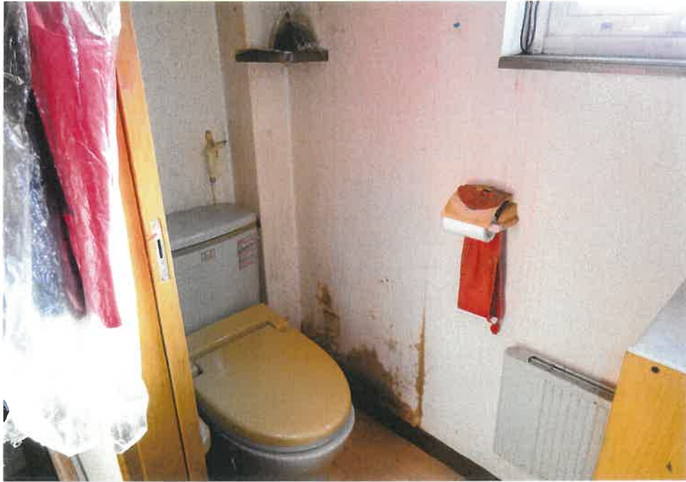
⑨ 1階 トイレ
