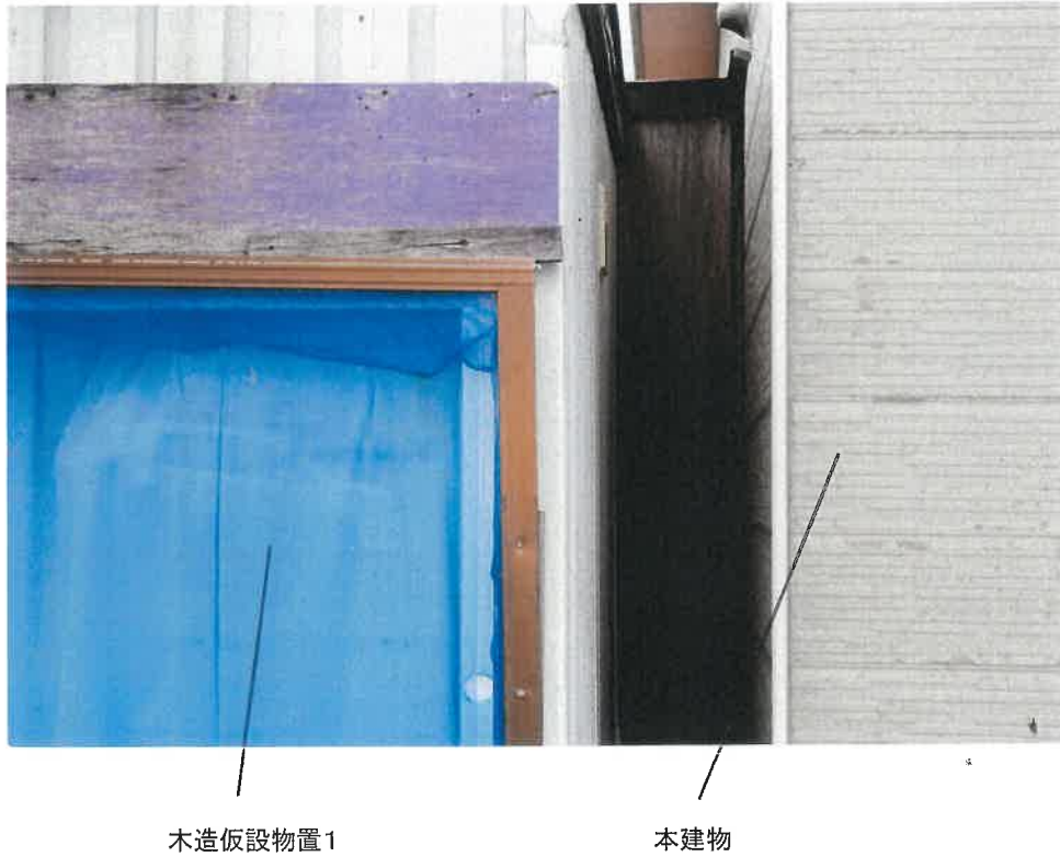
①⑨ 本建物と木造仮設物置1が接している状況
