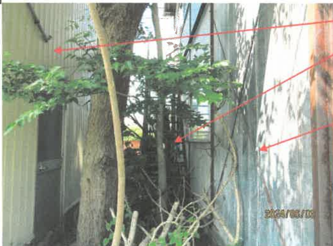
物件2 主たる建物
