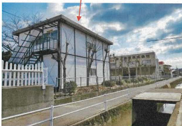
南西方市道の状況
