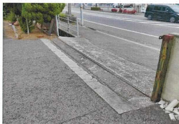
床版の設置状況
