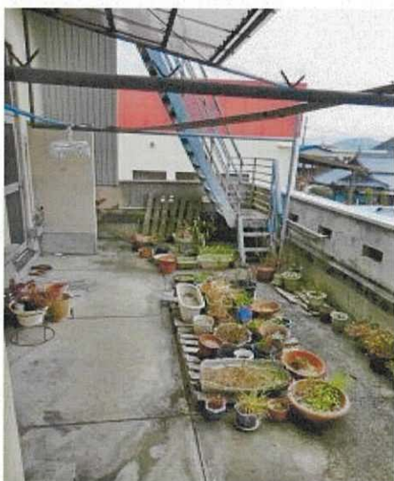
バルコニーの状況
