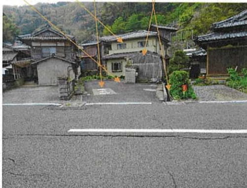
① 物件2主たる建物 物件2附属建物符号1 物件1 浄化槽 水路
