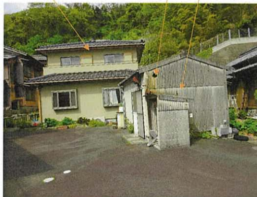
② 物件2主たる建物 物件2附属建物符号1 物件2附属建物符号1の損傷箇所
