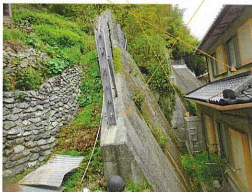
③ 物件1土地内に設置されているコンクリート擁壁 物件2 動産物置
