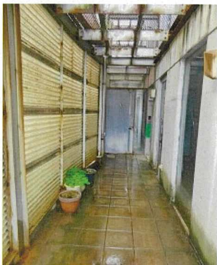
アプローチの状況
