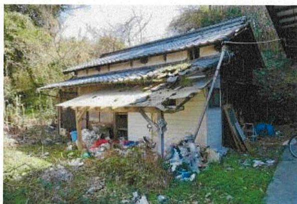
以下、物件2建物の状況
