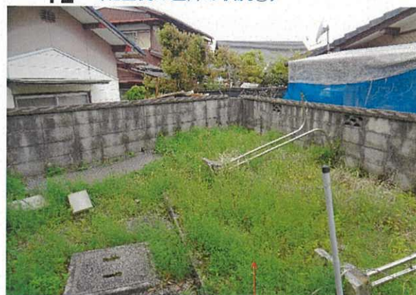
12 (北西側の囲障の状況①)
