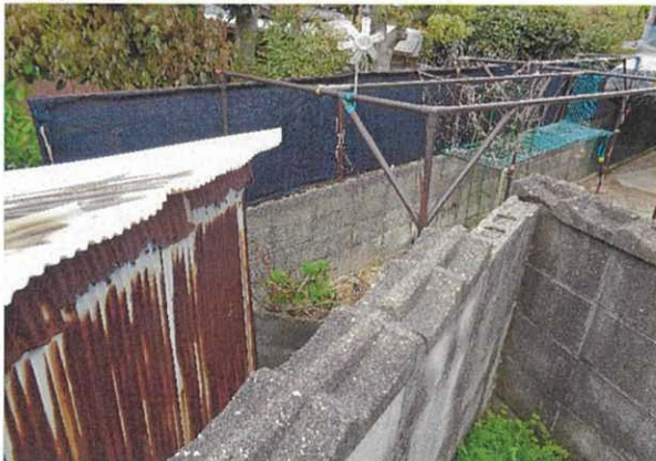
13 (北西側の囲障の状況①)
