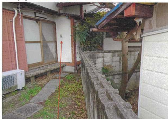
14 (北西側の囲障の状況②)
