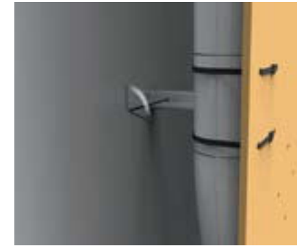
7. Particolare del fissaggio dei perni a parete.
