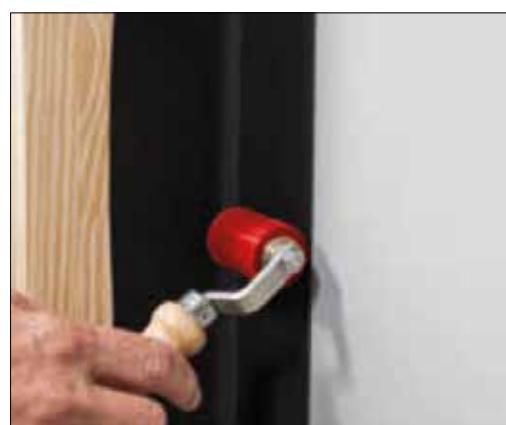
Maroufler pour bien fixer la bande. Ensuite, répéter l'opération de l'autre côté, en veillant à bien coller la rainure à l'aide d'une roulette d'angle en laiton.
