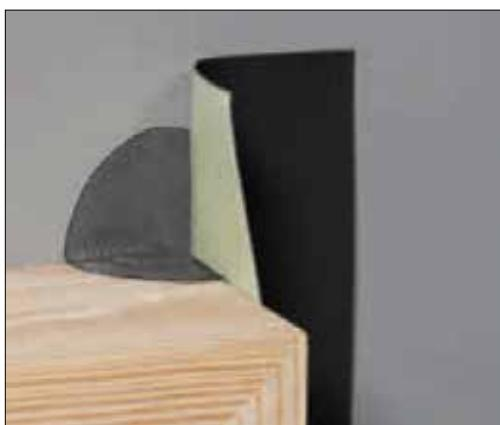
Plier la bande de Resistit G SK en deux et la placer dans l'angle. La laisser dépasser suffisamment au-dessus du châssis. Retirer le film pelable d'une moitié de la bande.
