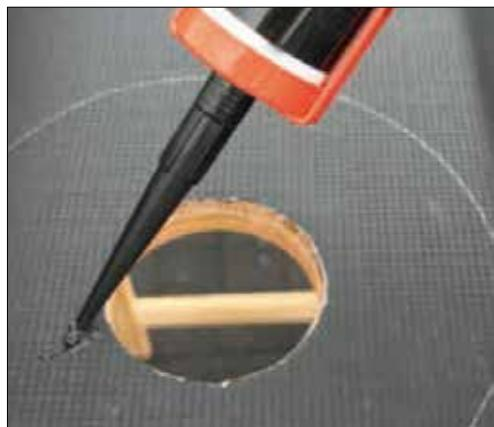
Appliquer des cercles de Resistit G SK mastic sur le support.
