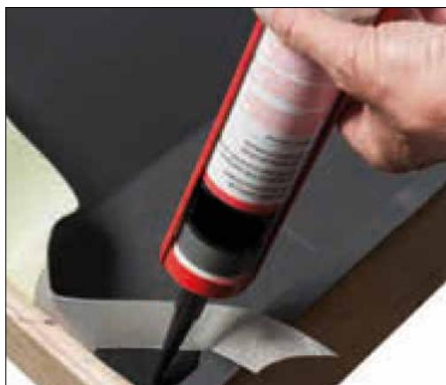
Appliquer du mastic entre les deux couches, puis comprimer le tout pour sceller. Appuyer fermement lorsque les angles sont totalement recouverts.
