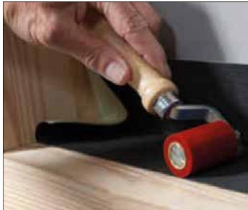
Maroufler. Répéter l'opération avec la 2ème moitié de la bande, en partant du milieu pour retirer le film pelable. Passer d'abord la roulette de compression en laiton dans la rainure, puis le rouleau en silicone sur la surface verticale.
