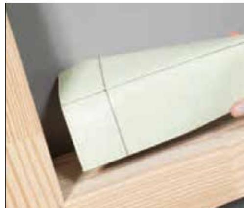
Couper le Resistit G SK sur la largeur, à 50 mm du bord.
