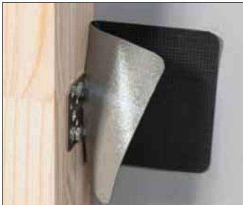
Replier la pièce sur la largeur et la placer dans la rainure. Ensuite, bien l'enfoncer à l'aide d'une roulette de compression. Retirer le film pelable du côté intérieur puis passer un rouleau de compression en silicone.
