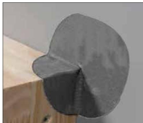
Appliquer un patch ou une pièce ronde de Resistit G SK sur la partie verticale et horizontale, puis sur le mur.
