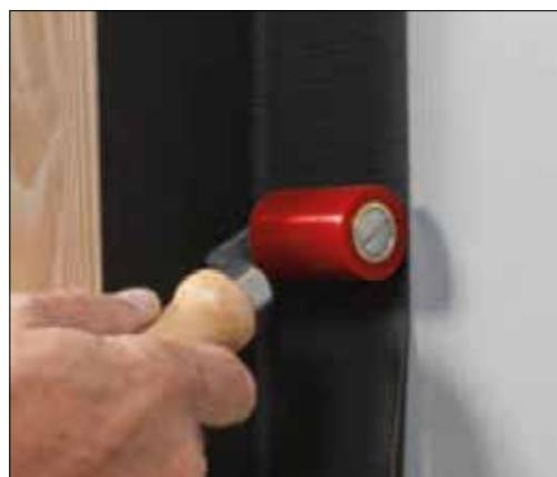
Retirer la moitié du film pelable dans l'angle. Coller cette partie sur le montant vertical. Ensuite, retirer le haut du film pelable et coller également cette partie sur le montant vertical, de sorte à façonner un angle. Passer d'abord la roulette de compression en laiton dans la rainure, puis le rouleau en silicone sur la surface verticale.
