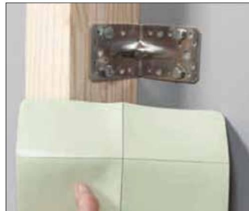
Découper une pièce de Resistit G SK supérieure au châssis. Entailler le film pelage en croix à l'aide d'un cutter.
