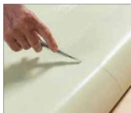
Pour faciliter la pose, couper le film pelable sur la largeur à différents niveaux pour procéder à l'encollage par étape du fond du chéneau.
