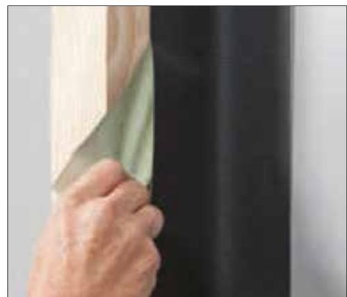
Plier la bande adhésive sur les lignes de découpe et la placer précisément dans l'angle. Retirer le film antiadhésif d'une moitié de la bande, par morceaux. Maroufler.
