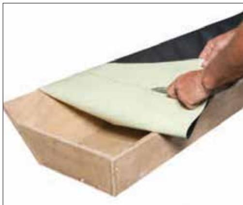
À l'extrême, retourner la bande sur la largeur. Inciser le film pelable de cette largeur à l'aide d'un cutter.
