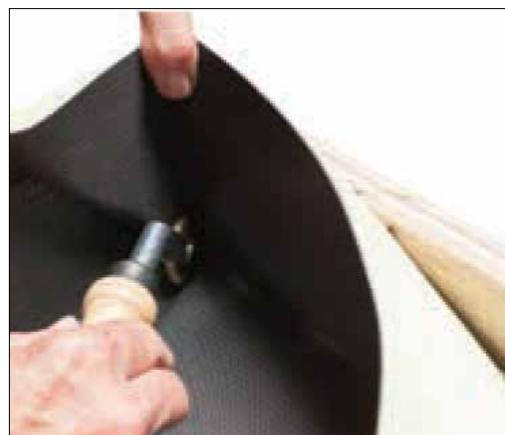
Plier la bande en angle façon pli mouchoir. Presser fortement les deux côtés de la bande dans l'angle à l'aide de la roulette en laiton.
