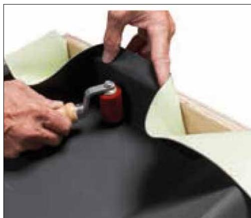
Passer le rouleau en silicone sur la partie de la bande qui n'a plus de film pelable, pour la coller sur le relevé d'extrémité.
