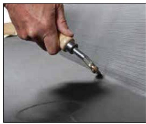
Pour finir, passer la roulette d'angle en laiton sur l'EPDM dans la rainure.
