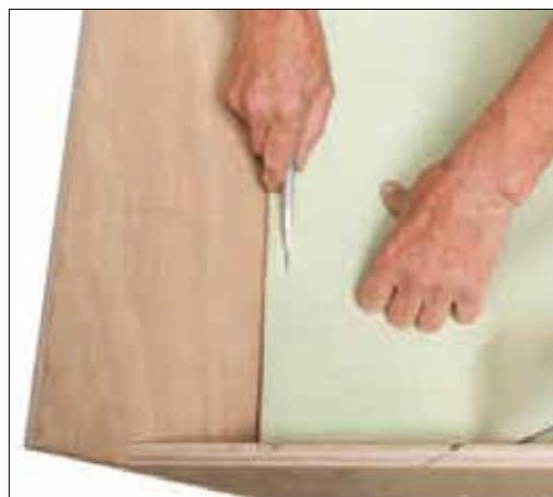
Plier la bande en deux dans le sens de la longueur. Couper le film pelable à l'aide d'un cutter. ATTENTION : Maintenir une distance d'env. 10 mm par rapport à la rainure.
