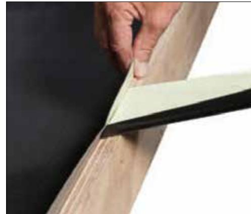
Commencer par coller le Resistit G SK dans un angle puis sur le relevé, en retirant le film par tronçons.
