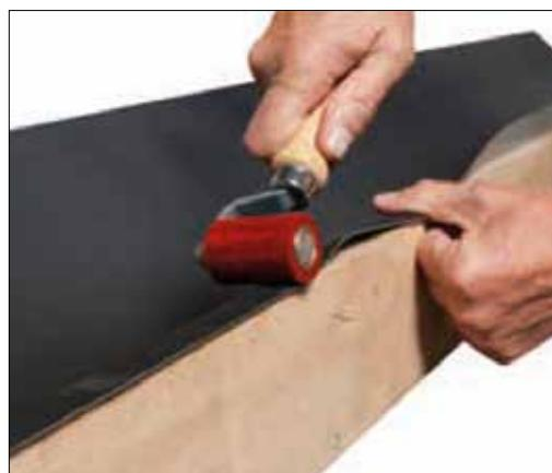
Passer le rouleau de pression en silicone sur le relevé du chéneau et sur le dessus.
