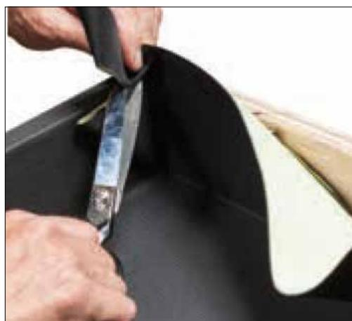
Réduire de moitié le pli en le découpant avec des ciseaux, pour que le bord soit parallèle au bord du chéneau mais un peu plus bas que celui-ci. Ensuite, couper la partie supérieure.
