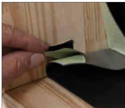
Retirer la moitié du film pelable dans l'angle. Coller cette partie sur le montant vertical. Ensuite, retirer le film pelable de la partie supérieure et coller également celle-ci sur le montant vertical. Procéder de sorte à façonner un angle.
