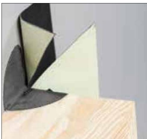
Couper proprement la bande d'un angle à l'autre. Retirer le film pelable et passer avec un rouleau de pression en silicone.
