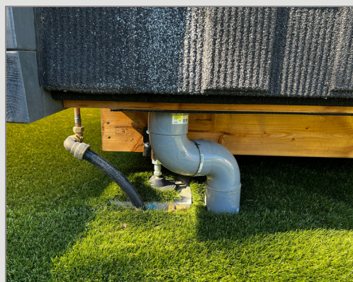
Evacuation des eaux usées, raccordement au PVC Ø 100mm
