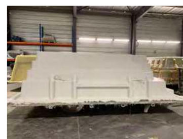
Pose des renforts + résine de protection
