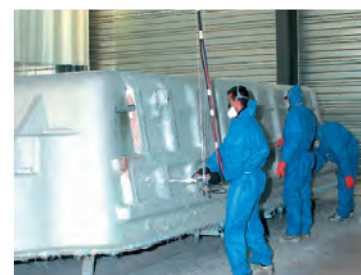
Pose des renforts + résine de protection
