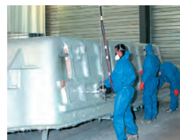
Pose des renforts + résine de protection
