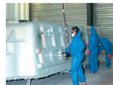
Pose des renforts + résine de protection
