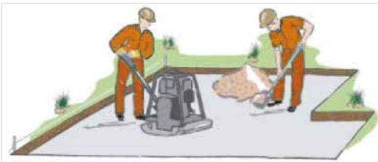
Tragschicht mit einem geeigneten Rüttler verdichten
