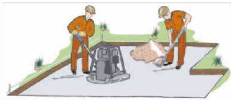
Tragschicht mit einem geeigneten Rüttler verdichten
