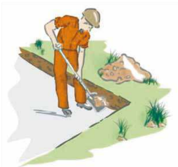
Nicht tragfähige Bodenschichten abgraben
